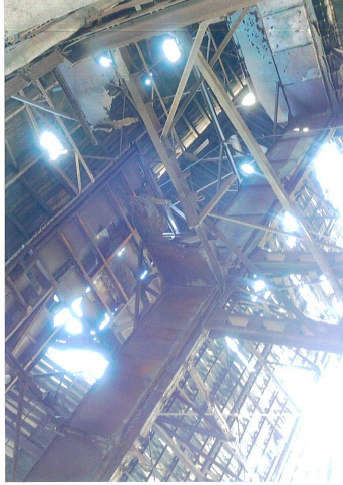
Kotłownia (część północna), konstrukcja dachu.
