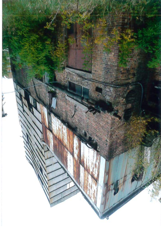
Przybudówka dla kotła OP-50 z lat 1967-1972 (widok od południowego zachodu).
