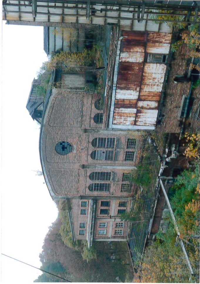
Elewacja południowa maszynowni i części biurowej; na pierwszym planie część obiektu dobudowana w latach 1967-1972 (pomieszczenia dla kotła OP-50 i transformatorów).
