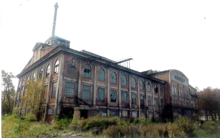
Elewacja północna (frontowa) i wschodnia
