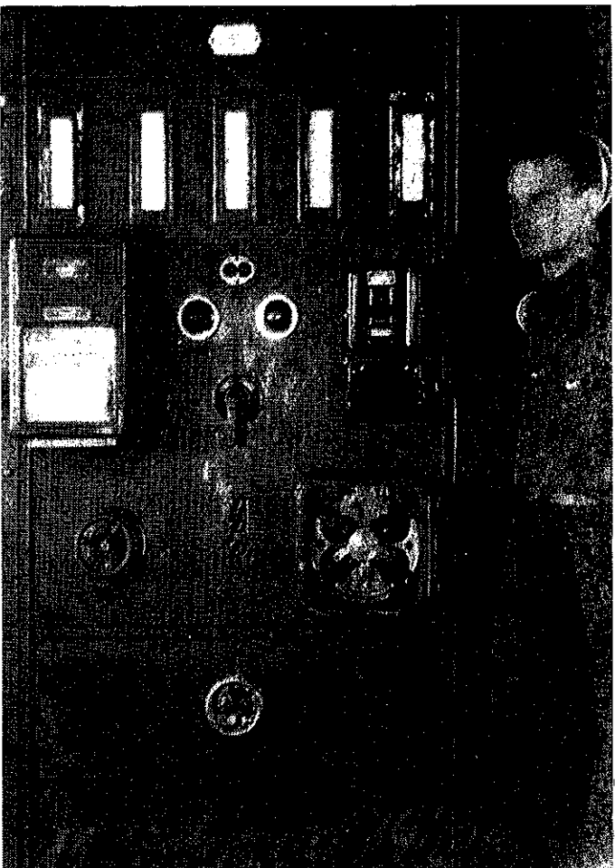
Rozdzielnia elektrowni (1945 r.)
