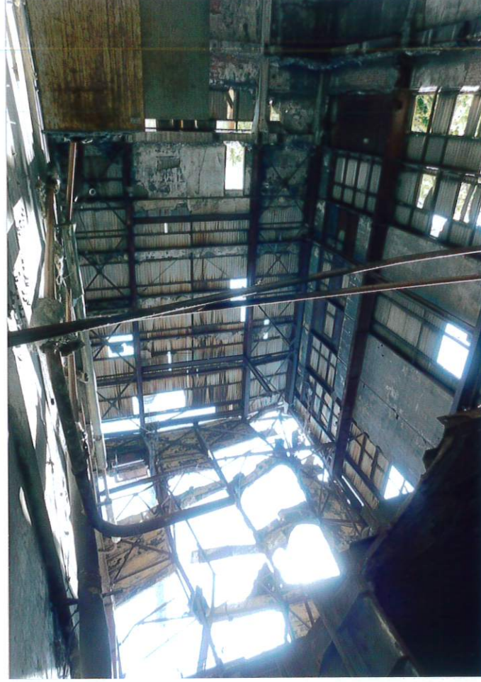
Kotłownia, część południowa; wnętrze przybudówki dla kotła OP-50 z lat 1967-1972.
